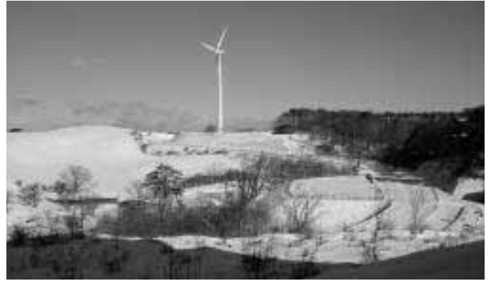
風力発電施設（里川町）
