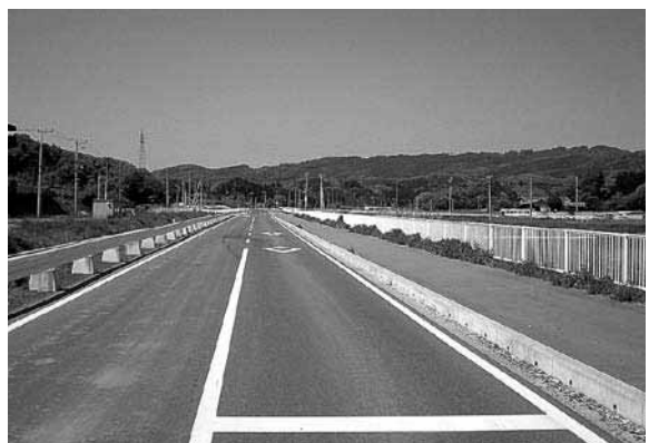
一部共用開始された国道293号バイパス(世矢小学校東側)
