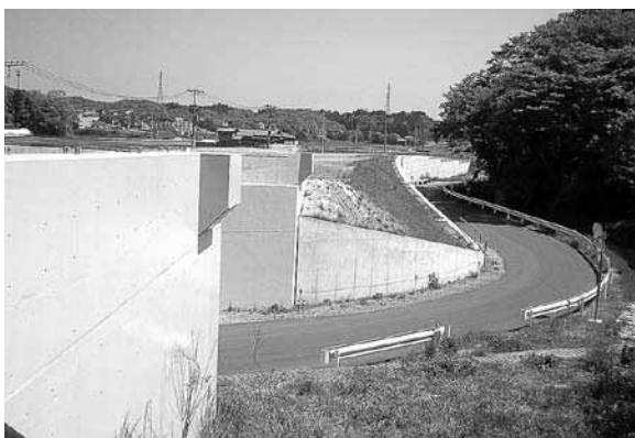
国道293号バイパス橋梁工事(真弓町)
