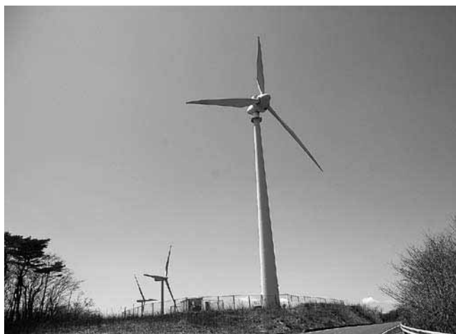
▲里美風力発電所（里美牧場内）
