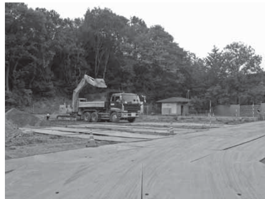
基礎工事が進む世矢中学校屋内運動場
