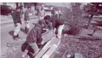
今回の震災で崩れた塀の撤去作業に取り組む内田町中自主防災会
