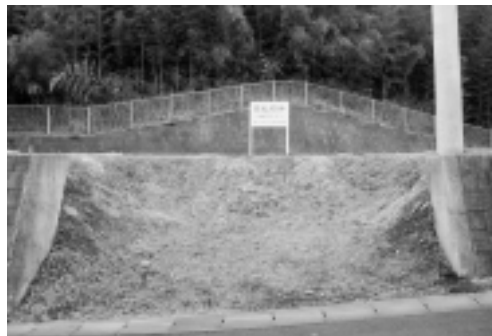
市は、ファシリティ・マネジメントの考え方に基づき市有地の売り払いを進めている（写真：天神林町）
