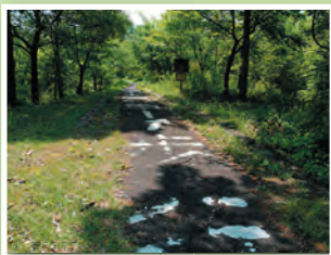
森の中にアスファルトの遊歩道が続く
