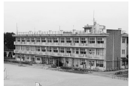
機初小学校大規模改修工事
