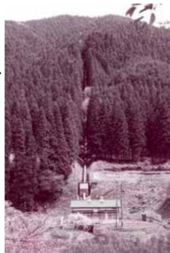
徳田発電所(平成11年撮影)
