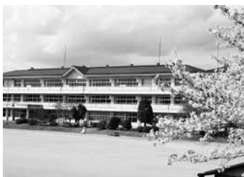
久米小改修工事
