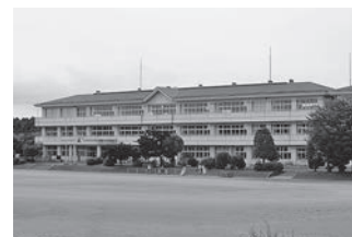
久米小学校校舎大規模改造工事
