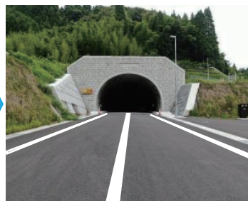
整備後（下高倉町側トンネル坑口付近）
