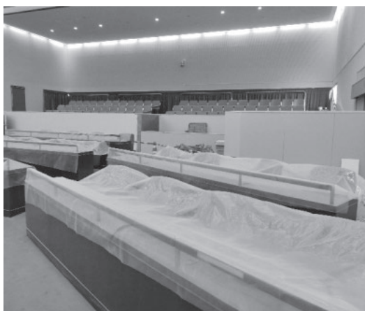
改修工事が進む議場（11月10日現在）
