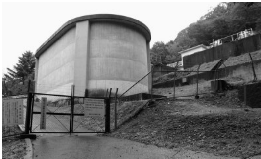
里美南部浄水場
