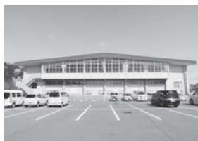
山吹運動公園体育館
