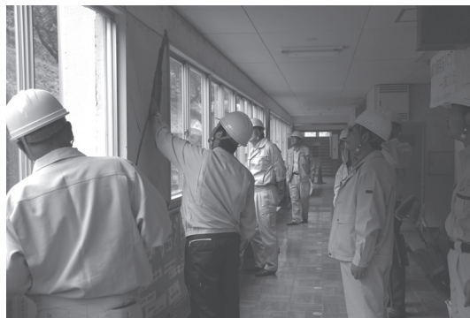
6/17 市内教育施設の被害状況を視察（佐都小学校）
