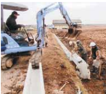
農地・水保全管理支払交付金を活用し、用水路の敷設替えをしている地元の皆さん
