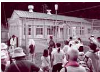
国登録文化財「小里川発電所」
