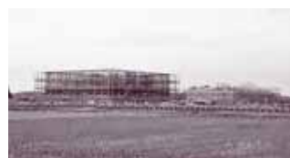
平成 26 年度稼働に向け整備が進む （仮称）新設浄水場（内田町）
