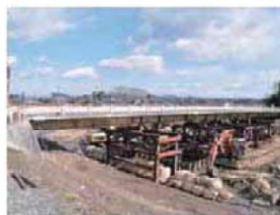
市道の橋りょう復旧工事も 急ピッチ（写真は善光寺橋）
