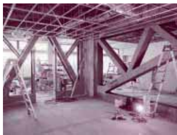
耐震化工事が進む市役所本庁舎1階
