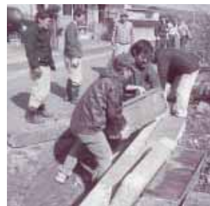
東日本大震災で倒壊した塀を撤去する内田町中自主防災会
