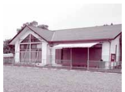
コミュニティの拠点・下利員公民館。“グリーンカーテン”と“ひさし”は手づくり
