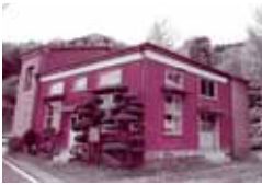
今も残る旧町屋変電所。 町屋発電所の変電施設と して、明治42年に建設。 当時の人々は「電気見た けりや町屋へ行け」と自 慢したという
