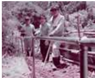
滑りやすい斜面の道には金属の手すりを設置した
