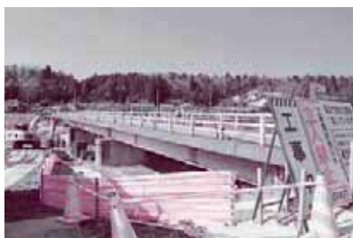
松栄橋…平成 24 年 6 月完成予定
