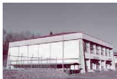
世矢中学校体育館…平成 25 年 2 月新設復旧予定
