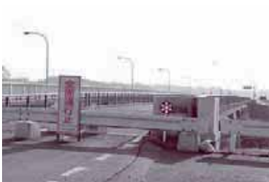
里川橋（県事業）…平成 23 年度仮設橋設置。本工事は平成 24 年 11 月頃から。平成 25 年度完成予定
