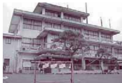
金砂郷支所…現在の建屋は解体し、平成 25 年度に新設整備予定
