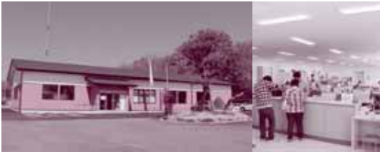
鉄骨プレハブ平屋建て。延べ面積は約437㎡。庁舎の壁には市内の木材を使用し、庁舎内の照明はLEDで太陽光発電も利用
