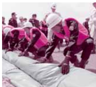
水防工法の基本となる土のうを作る作業【土のうごしらえ】
