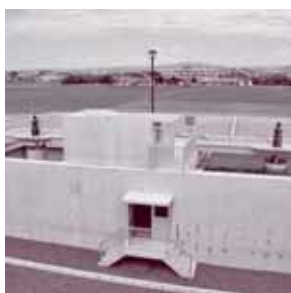
災害時には給水拠点として利用される内田浄水場
