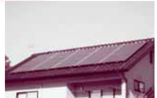
太陽光発電システム
