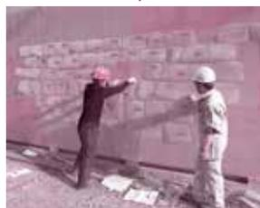
崩れた石一つずつの型紙を試行錯誤しながら並べ、元の位置を確認したうえで再び積み上げました。破損等で使えない石は、新たに長崎県諫早の石で置き換えました。
