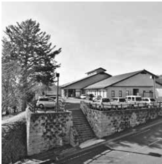
里美温泉のぬくもりが楽しめる改修工事が行われる里美温泉保養センター
