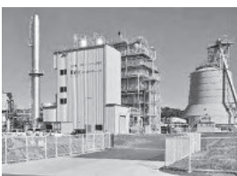
宮の郷木質バイオマス発電所
