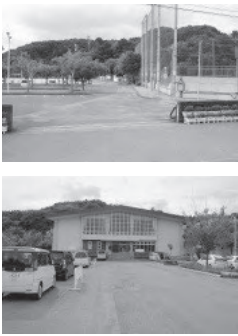
山吹運動公園野球場・体育館前の駐車場を整備
