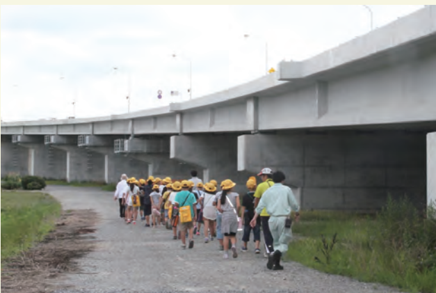
地元の小学生が完成した橋の風景を見学しました。
