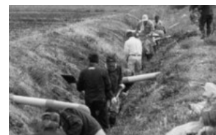
排水路の泥上げ作業
