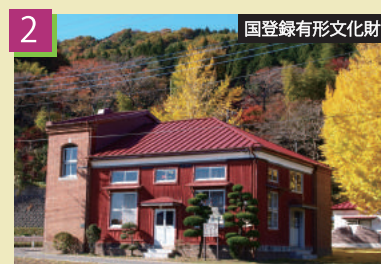
旧町屋変電所 きゅうまちやへんでんしょ
