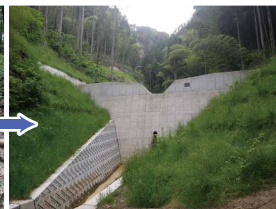
完成した谷止工
