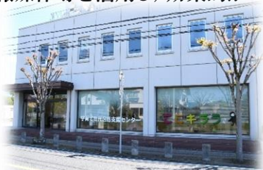
「ここキララ」の外観
