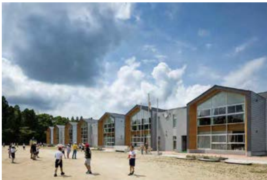
新しく整備された校舎(水府小・中学校)
