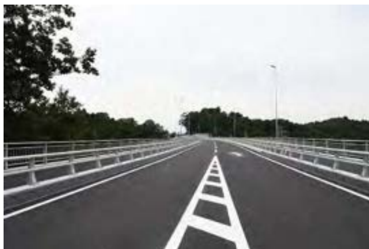
国道293号線バイパス(長尾橋)
