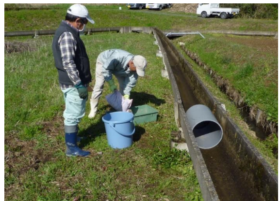
・水路の軽微な補修 (漏水防止のための目字詰め)
