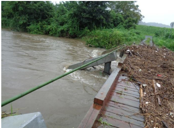
・異常気象時の対応(大雨後の見回り)
