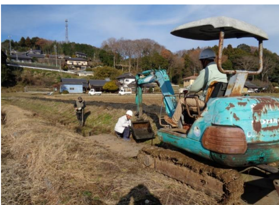
・水路の泥上げ作業
