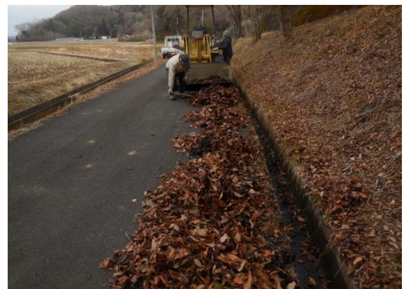
・農道側溝の泥上げ作業
