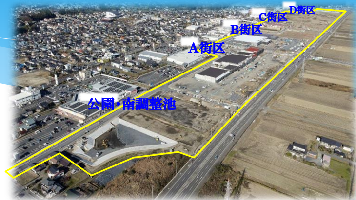
東部地区（造成工事・店舗建築進捗状況）
