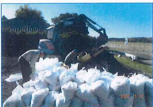
・土嚢を使っての裏込め材の充填作業
