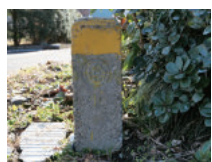
③ 里川土手に残る跨線橋橋台付近に残る日立電鉄の用地境界杭。廃線になった線路沿いにたくさんみられる。
