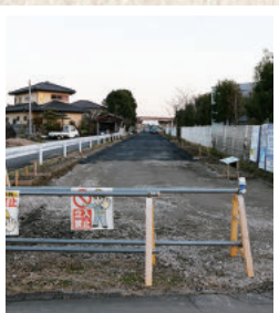
② 国道349号バイパス東側。県の合同庁舎北側の線路跡道路転用に向けて工事中。
