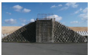
④ 国道349号バイパス東側から里川への道路転用区間の終点。跨道橋の橋台が片側だけ里川土手に残る。
