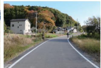
⑩ 川中子ー常陸岡田間、国道293号アンダーパスより東側。線路を道路に転用している区間。
