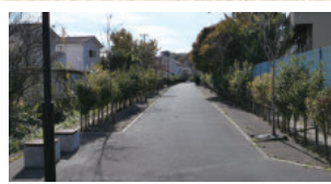
㉕ 常磐線とのトンネル交差を抜けた先、久慈浜駅へと続く線路は歩行者用の道に転用。
