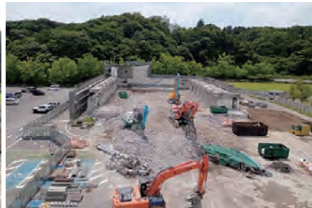
体育館解体状況(6月26日)
