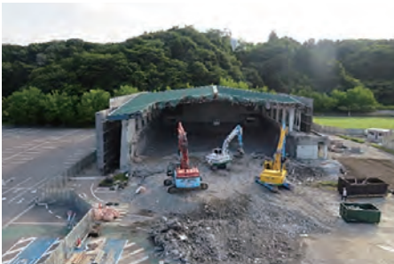
体育館解体状況(6月21日)
