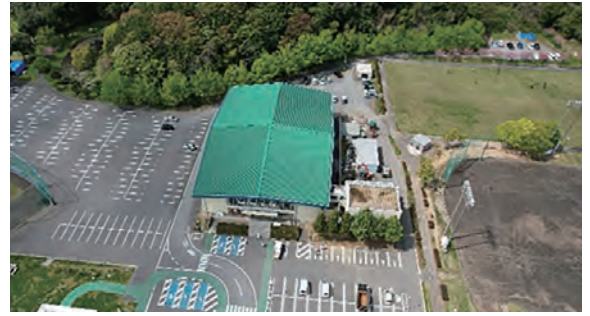
工事着手前(4月12日)
