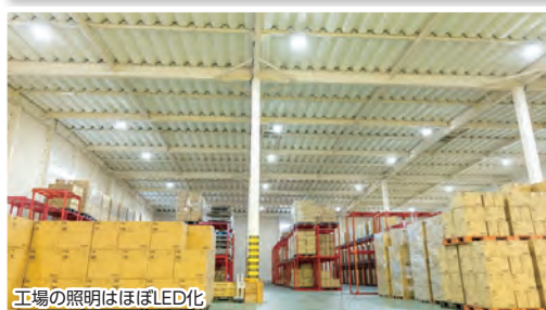
工場の照明はほぼLED化
