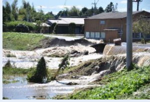
令和元(2019)年台風19号による河川氾濫
