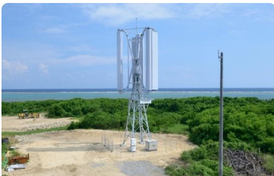
沖縄県の離島における実証試験の様子 70mの風速に耐える地上20mの縦型風力発電施設 【出典：©株式会社チャレナジーHP】
