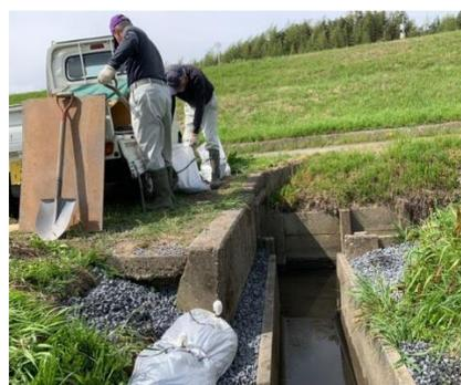
水路継ぎ目からの漏水により側溝脇陥没箇所を補修しました。
