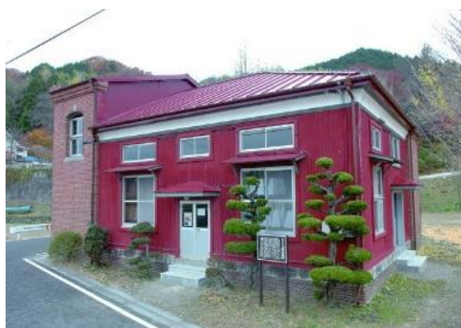
旧町屋変電所
