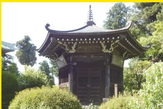
都々一坊扇歌堂（石岡市）
