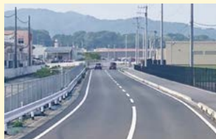
●中央線や車両通行帯が設けられている一般道路
