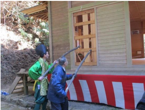
（写真）羽目板抜き
