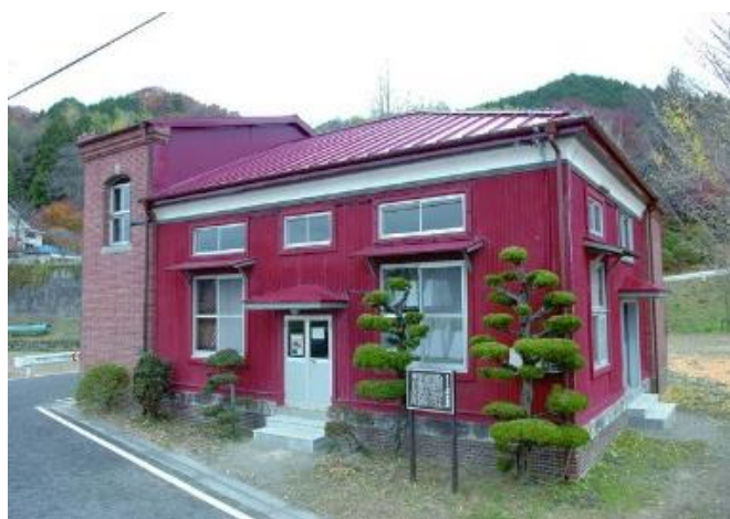
旧町屋変電所
